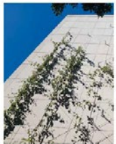
Grimpantes sur treille de câbles, avenue Courcelles, programme S 0003a, Paris 15 e . La grimpante de câble disparaît-elle sous le couvert végétal ?
