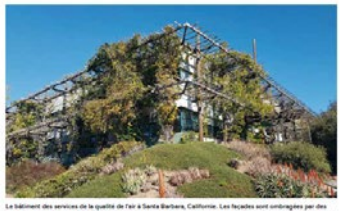
Le bâtiment des services de la qualité de l'air à Santa Barbara, Californie. Les façades sont couvertes par pergolas et des bras-solés câbles qui constituent une structure support en trois dimensions pour les grimpantes.
